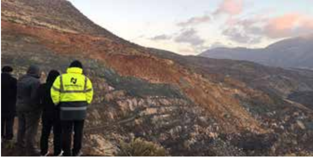
Şekil 16: 2016 yılında Şirvan (Siirt) da meydana gelen göçükten genel bir görünüş (14)
